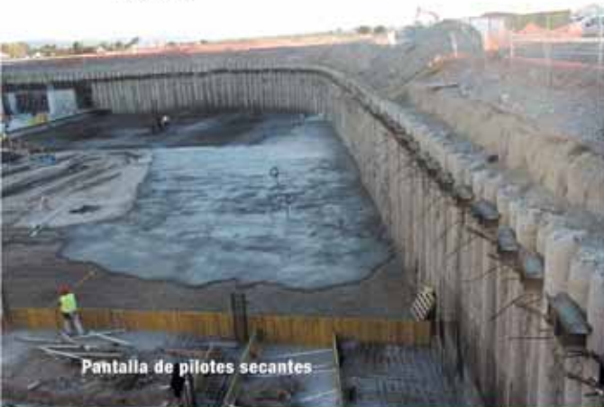
Pantalla discontinua de pilotes anclada en viga de coronación y en viga intermedia
