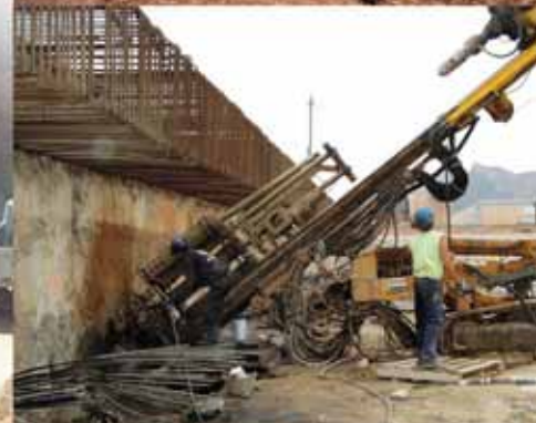
Tesado de anclajes multibulbo de hasta 200 T por anclado
