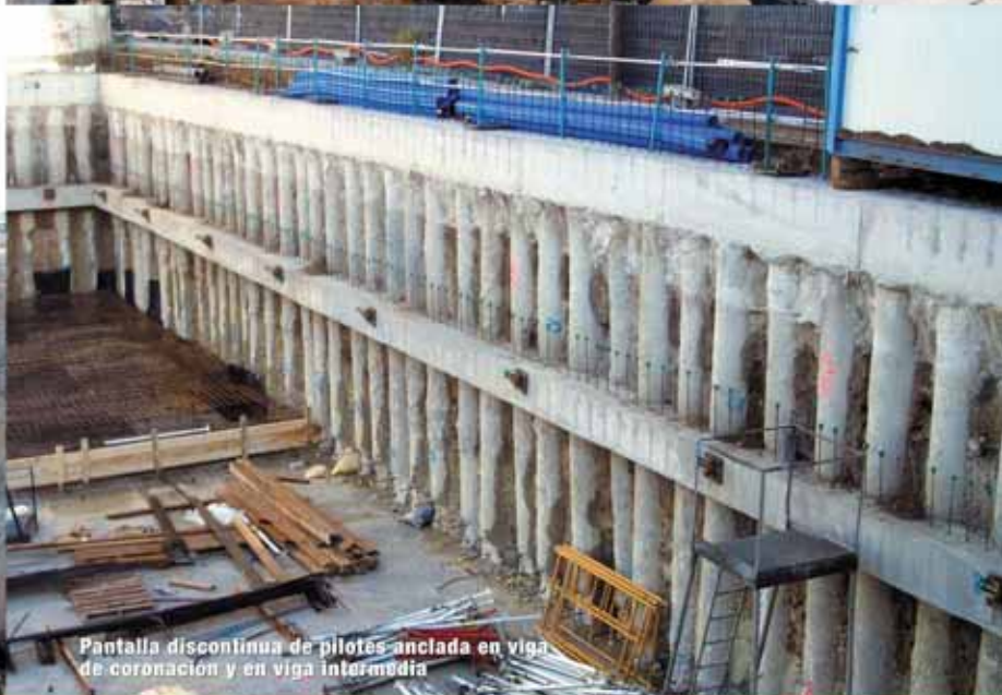
Pantalla discontinua de pilotes anclada para nuevo estadio Mestalla, Valencia C.F.
