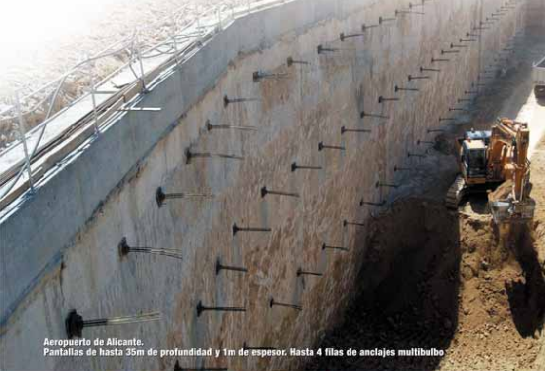
Tesado de anclajes multibulbo de hasta 200 T por anclado
