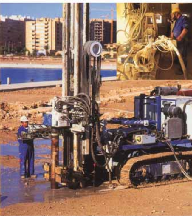
Aeropuerto de Alicante. Pantallas de hasta 35m de profundidad y 1m de espesor. Hasta 4 filas de anclajes multibulbo
